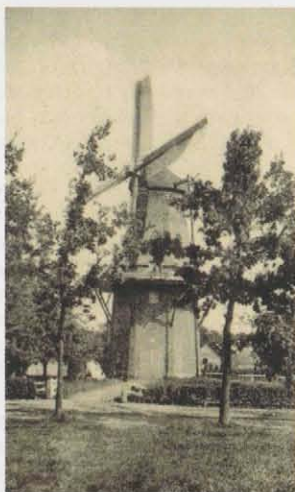
1. Foto van de graanmolen in de Heerestraat in Roden, bouwjaar 1892, afbraak 1920
